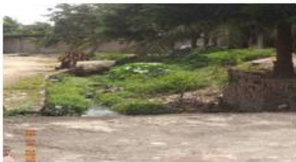
Vista do canal na rua Dr. Procópio
