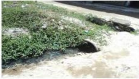
Tubulação de esgoto a céu aberto
