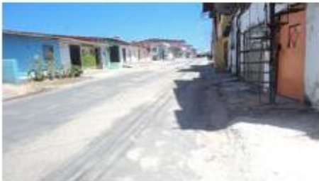
Rua asfaltada da Comunidade Unidos Venceremos.
