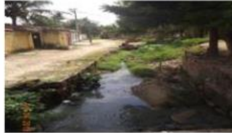
Vista do canal na rua Dr. Procópio
