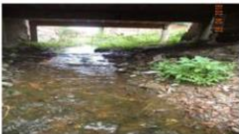
Vista do canal na rua H
