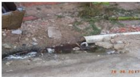
Esgotamento a céu aberto. Rua Jornalista Antônio Pontes Tavares
