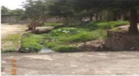
Vista do canal na rua Dr. Procópio
