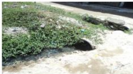
Tubulação de esgoto a céu aberto
