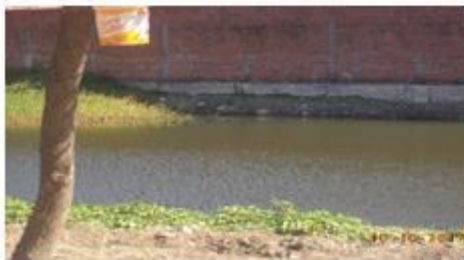
Área inundada na Rua Jornalista Antônio Pontes Tavares
