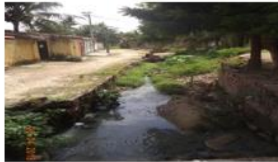
Vista do canal na rua Dr. Procópio
