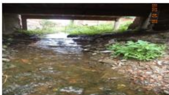
Vista do canal na rua H
