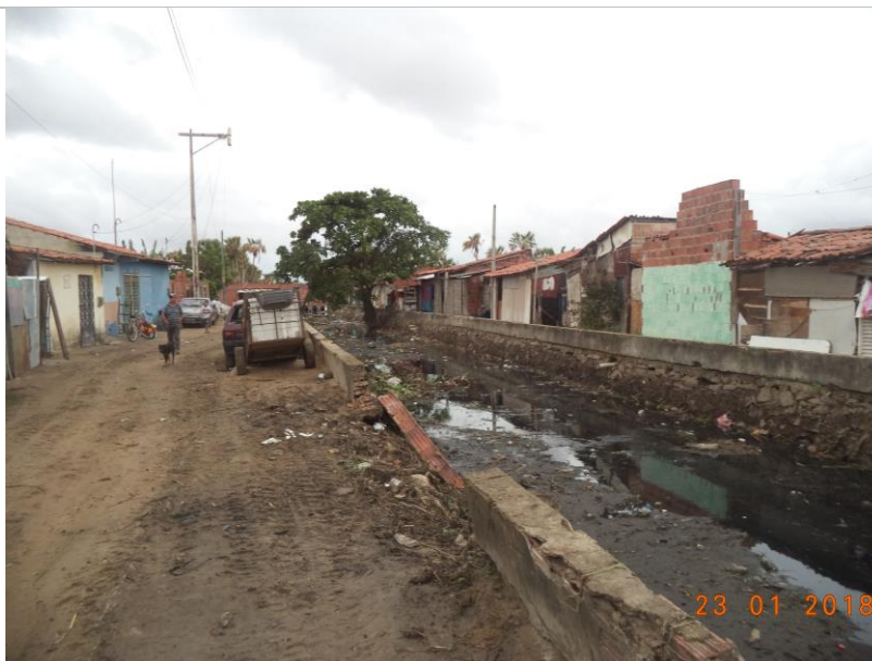
Foto 1 – Canal a ser reconstruído
