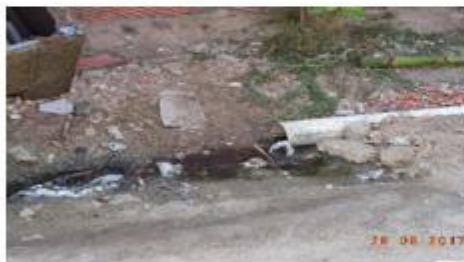
Esgotamento a céu aberto. Rua Jornalista Antônio Pontes Tavares
