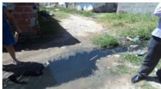
Esgotamento a céu aberto
