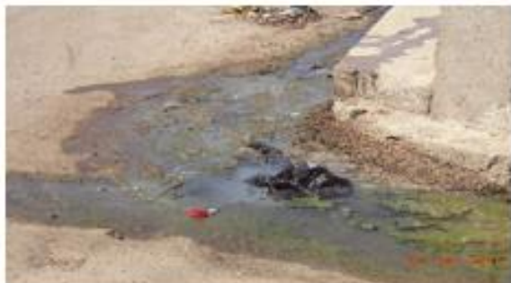
Esgoto a céu aberto na Rua Estudante Ana Kelly
